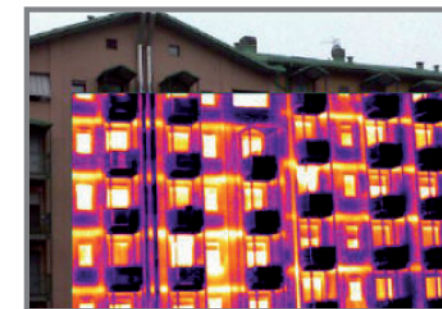
Termocamera FLUKE Scansione Termografica Condominio
